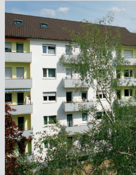
In der Buchenstraße 8-10 wandeln sich die Wohngebäude nach ihrer energetischen Vollmodernisierung zu „besseren“ Energiesparhäusern.
