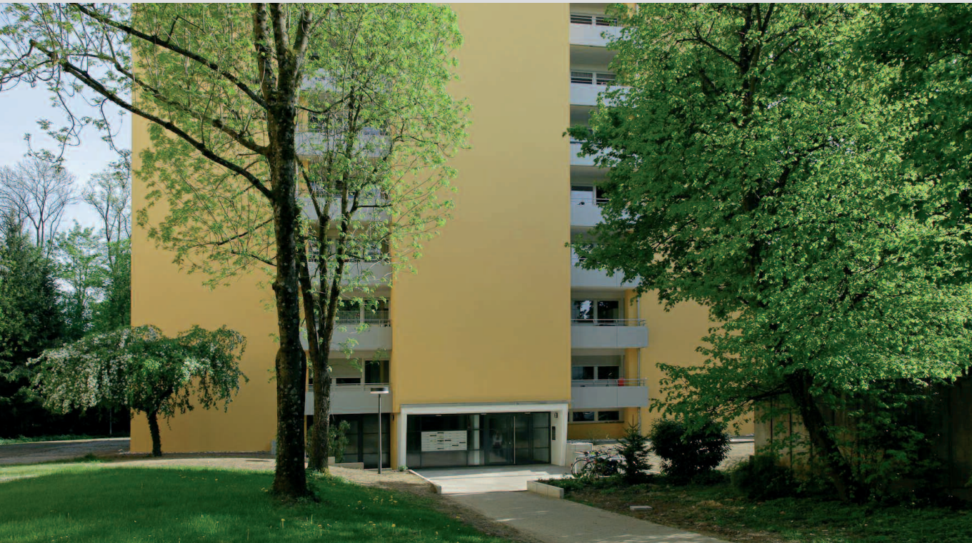
Vollmodernisiert – der Moosgrund 18 mit Vollwärmeschutz, modernen Bädern, sanierten Balkonen und zeitgemäß gestaltetem Hauseingangsbereich
