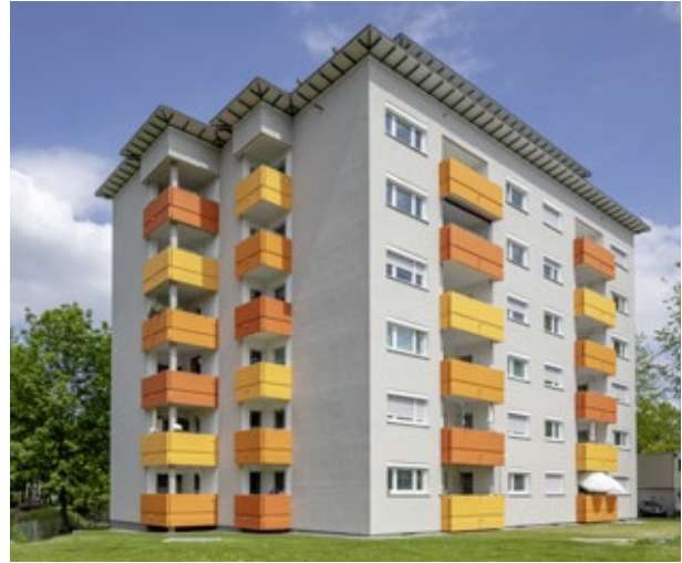
Saniertes Haus in der Charlottenburger Straße 5
