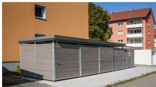
In der Stuttgarter Straße in Freiburg-Zähringen können sich die Mieterinnen und Mieter über neue Müll- und Fahrradhäuser freuen.
