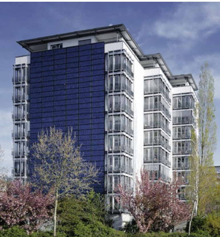
Photovoltaik an der Wilmersdorfer Straße 3+5
