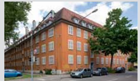
Instabile Bodenverhältnisse erfordern den Rück- und Neubau
