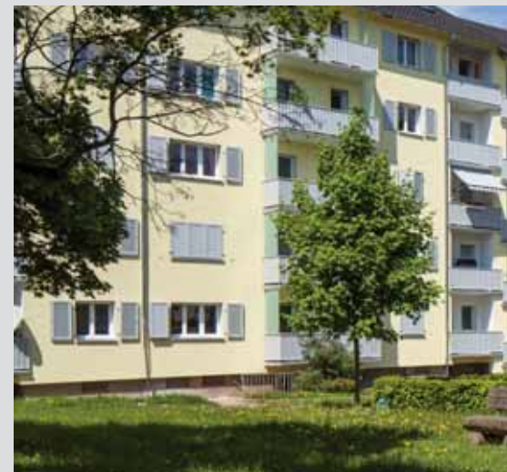
Energetisch modernisiert - die Zähringer Straße 27-33
