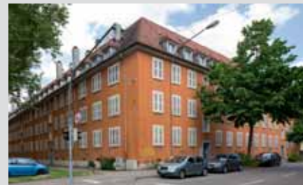
Instabile Bodenverhältnisse erfordern den Rück- und Neubau
