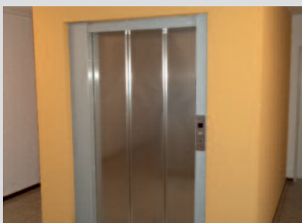
300.000 Euro wurden 2013 in die modernen Aufzüge Auwaldstraße 15-25 und Moosgrund 18 investiert.
