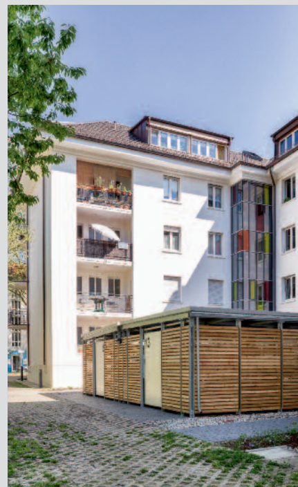
Oberau: Im Innenhof Runzstraße 13+15 wurden ansprechende Fahrradhäuser errichtet.
