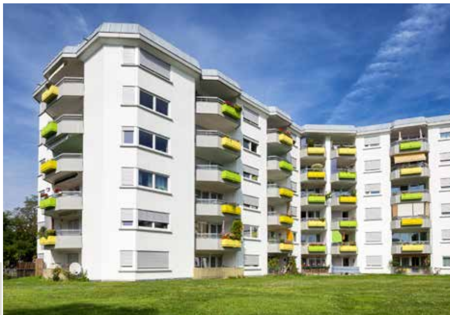
Sanierungsobjekt Bissierstraße 2–12, 18+20, Freiburg
