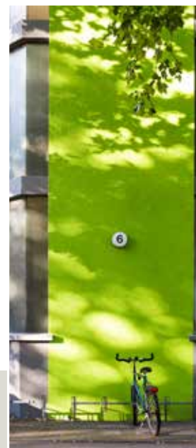
Sanierungsobjekt Bissierstraße 2–12, 18+20, Freiburg / Detail Fassade
