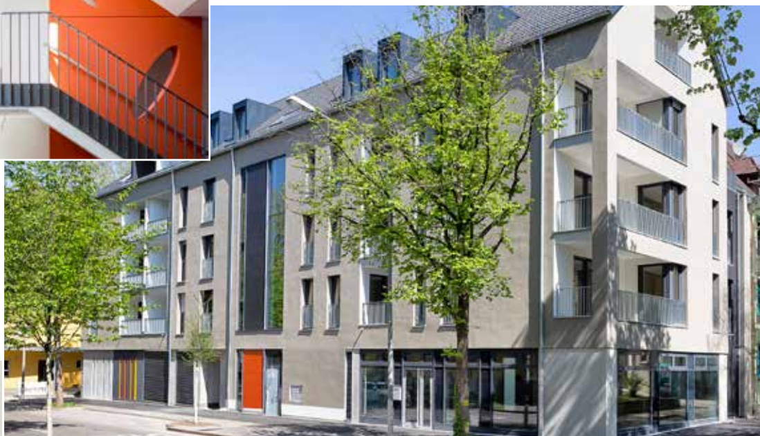
Neubau Rennweg/ Konturstraße, Freiburg Aussenansicht und Detail Treppenhaus
