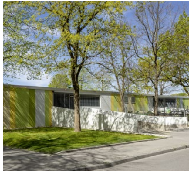
Die sanierte Tiefgarage Auwaldhof
