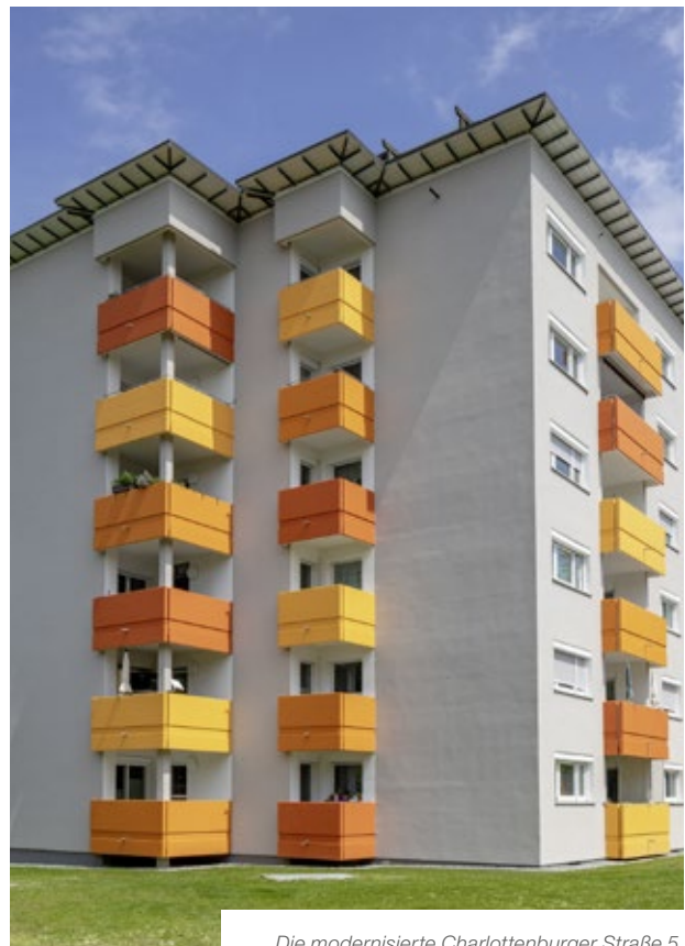
Die modernisierte Charlottenburger Straße 5
